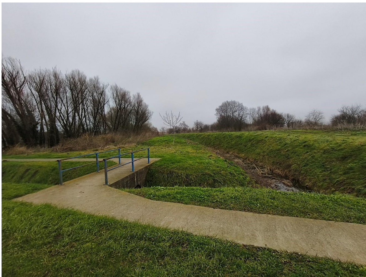
Slika 26. Spoj kanala na k.č. 862 k.o. Ernestinovo s kanalom južno od prometnice i nadsvođeni dio radi biciklističke staze
