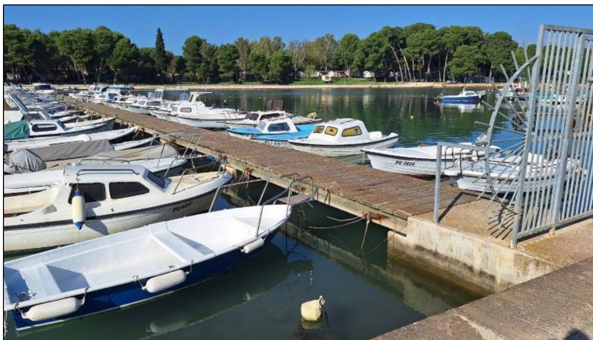
Slika 7. Pogled na jedan od gatova luke „Valbandon“
