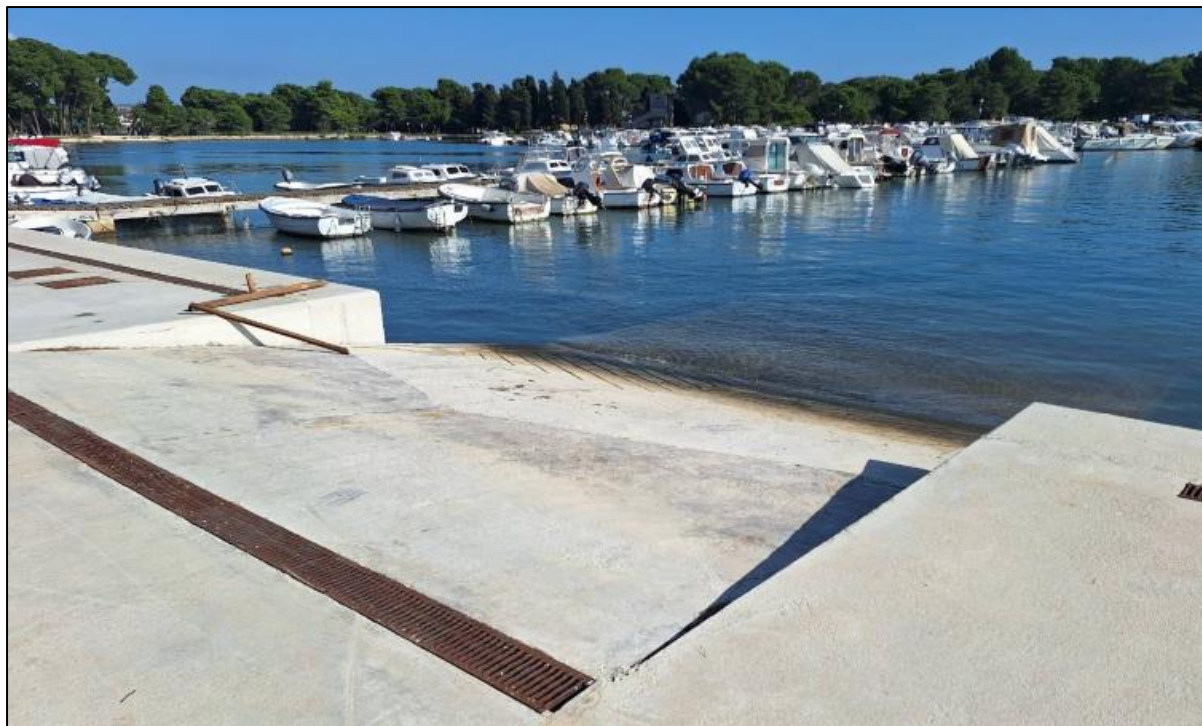
Slika 8. Pogled na istezalište u zapadnom dijelu luke „Valbandon“
