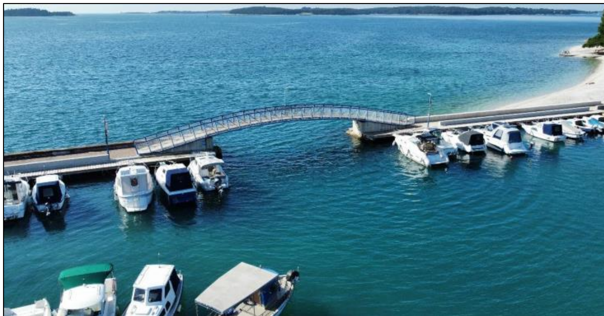
Slika 6. Pogled na ulaz u luku „Valbandon“ i pješački lučki most
