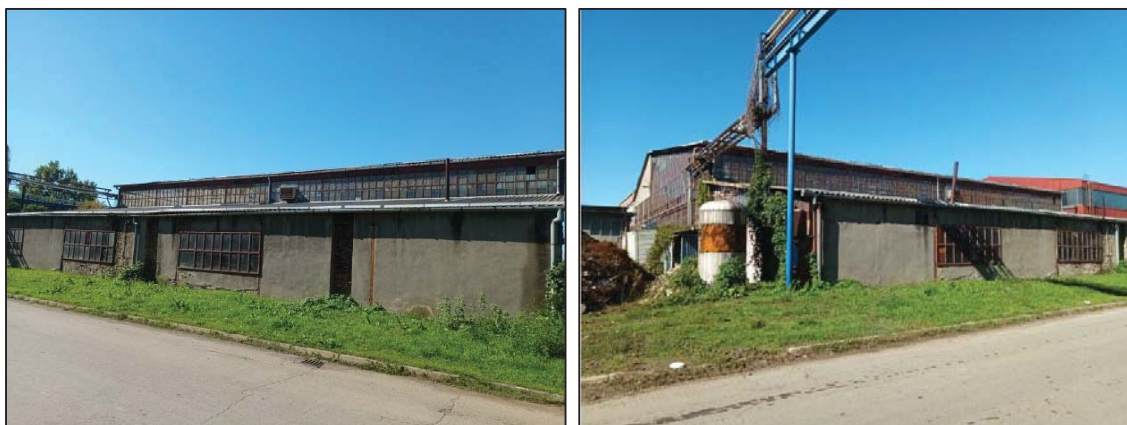
Slika 6. Istočno pročelje postojeće zgrade - hale (izvor: Snimak izvedenog stanja za prenamjenu hale u skladište neopasnog otpada od metala, GX-PROJEKTI j.d.o.o., lipanj 2025.)
