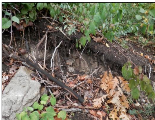
Slika 27. Usjek uz rub postojećeg iskopa
