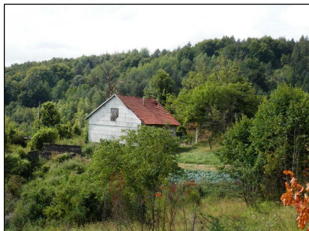
Slika 43. Objekt u Kostelićima najbliže lokaciji
