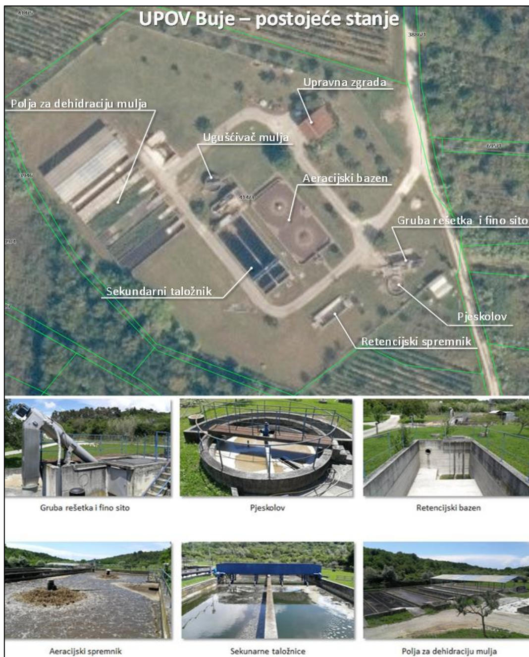
Slika 27. Postojeće građevine i oprema na lokaciji UPOV-a Buje
