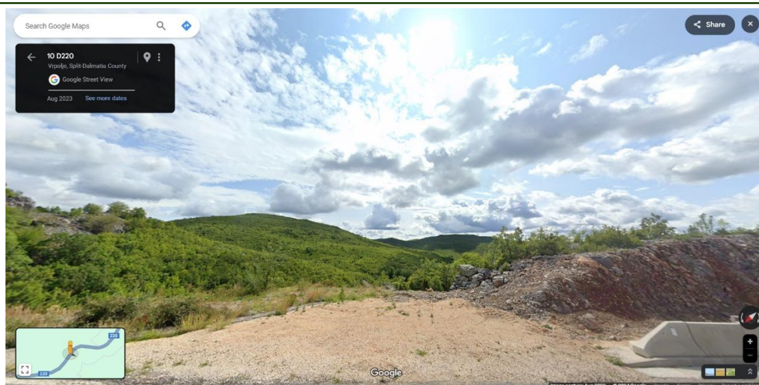
Fotografija 3-3: Pogled sa stacionaže 4+500 južno prema odsjeku privatnih šuma 32a
