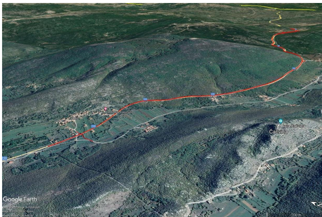
Grafički prikaz 2-25: Pogled iz zraka na početni dio planirane rekonstrukcije DC220 u smjeru jugoistoka
