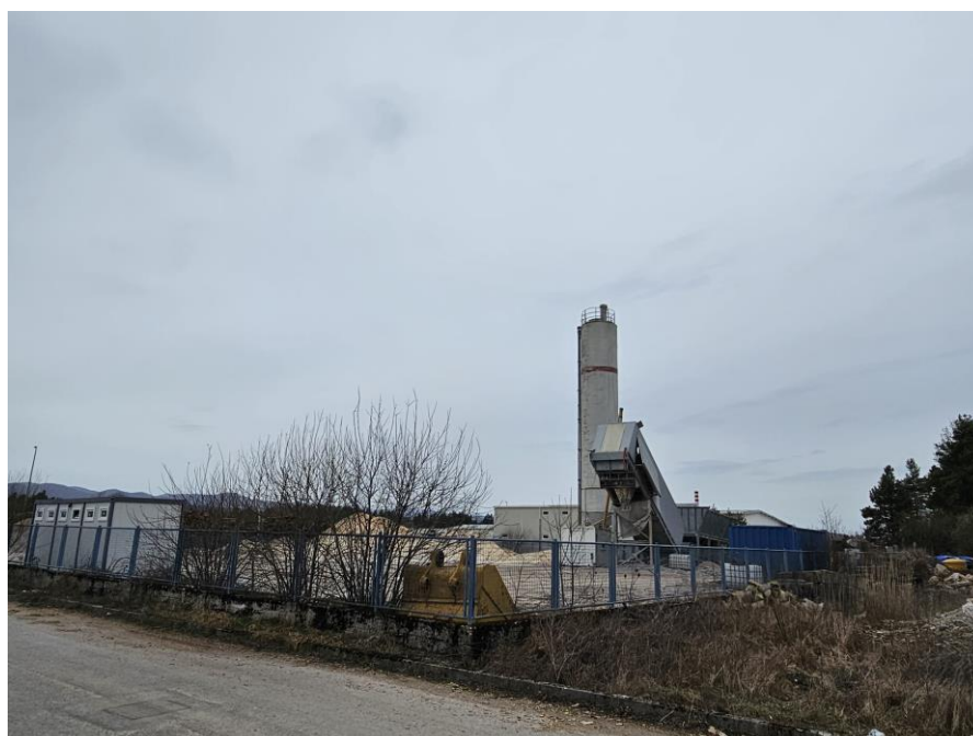
Sl. 3.8-4: Betonara na katastarskoj čestici sjeverno od lokacije zahvata
