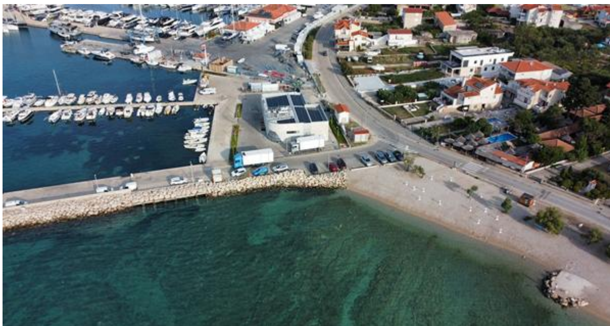
Slika 1.1 - 2 Postojeće stanje plaže Bristak, pogled prema lukobranu na zapadnom dijelu plaže (Izvor: Zeleni servis d.o.o., 27.08.2025)
