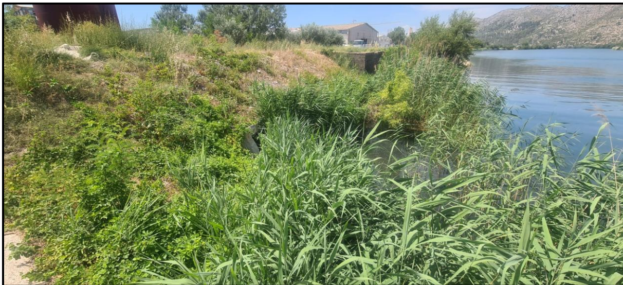
Slika 2.1-4. Postojeći ispust u Neretvu
