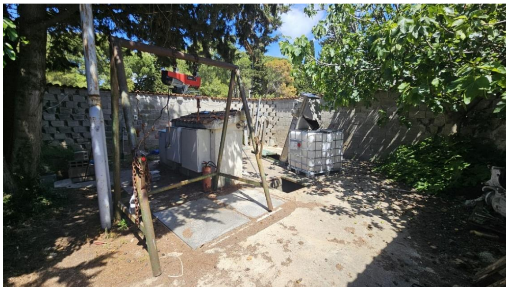
Slika 1.3 Postojeća glavna crpna stanica
