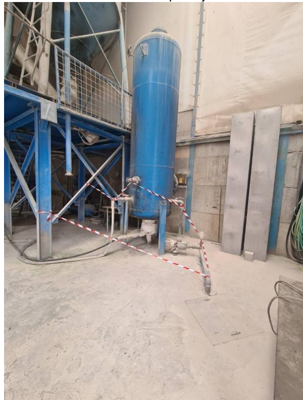
Zdenac EZ-2 kod betonare
