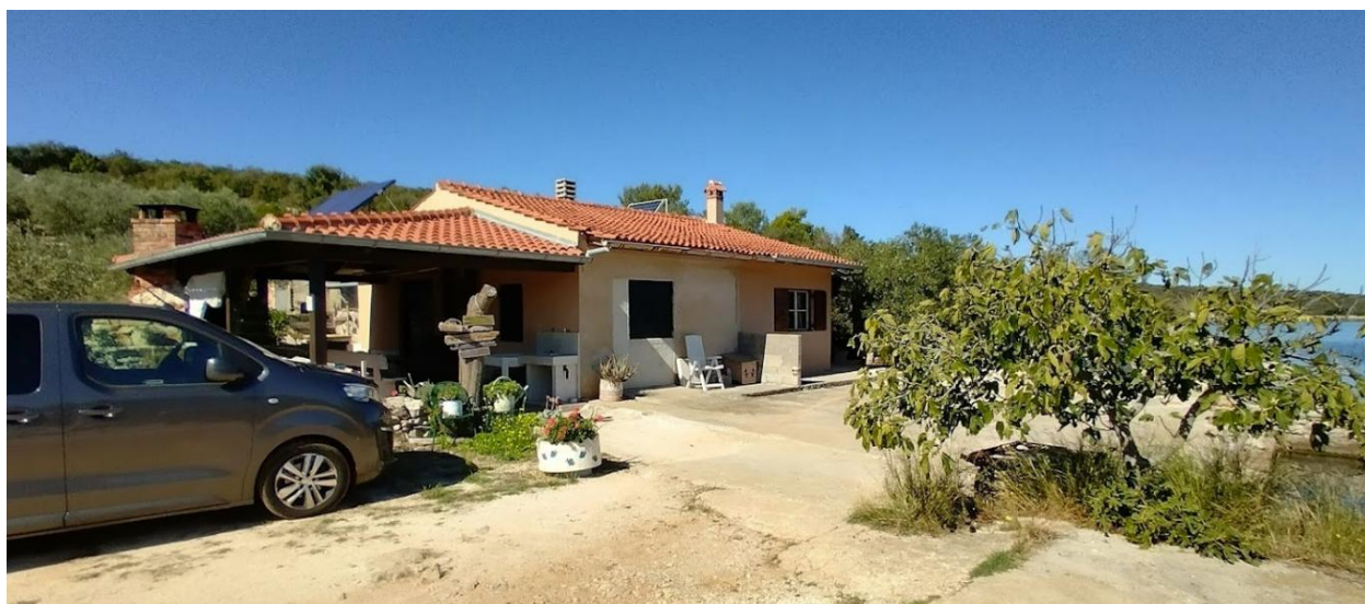
Slika 3.3-8 Ribarska kuća (izvor: Google Maps)
