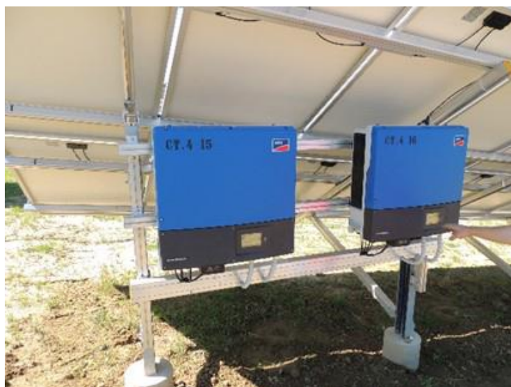
Slika 1.7 Koncept smještaja izmjenjivača male snage
