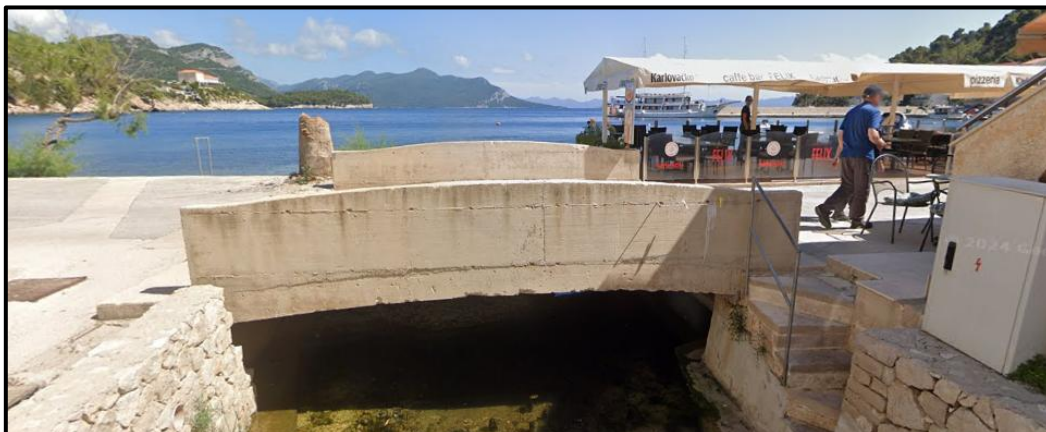
Slika 4.3.1-1. Propust na ušću bujice Trstenik (JKR00760_000000): u koridoru obalne prometnice na kojoj je izveden propust trasirani su zahvatom planirani cjevovodi odvodnje i vodoopskrbe
