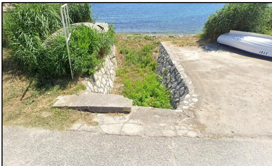
Slika 4.3.1-2. Propust na ušću bujice Mali Trstenik: u koridoru obalne prometnice na kojoj je izveden propust trasiran je zahvatom planirani cjevovodi odvodnje
