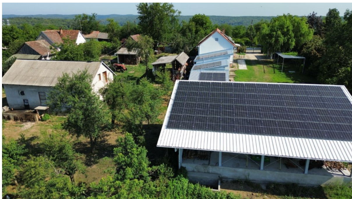
Slika 22. Postojeće stanje na lokaciji zahvata na dan 09.07.2024
