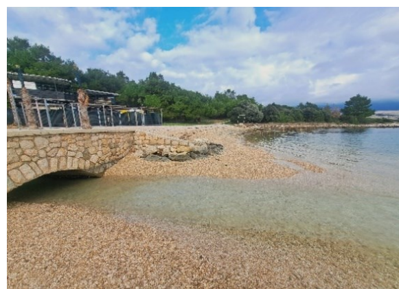
Slika 5.9. Prozor mora kroz kanal (UIH d.o.o., 2023.)
