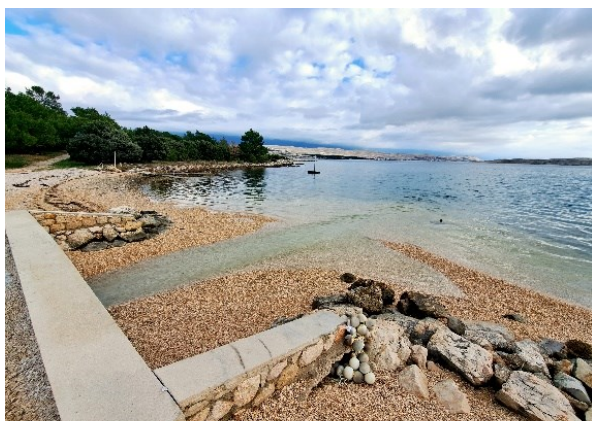
Slika 5.7. Prozor mora kroz kanal (UIH d.o.o., 2023.)
