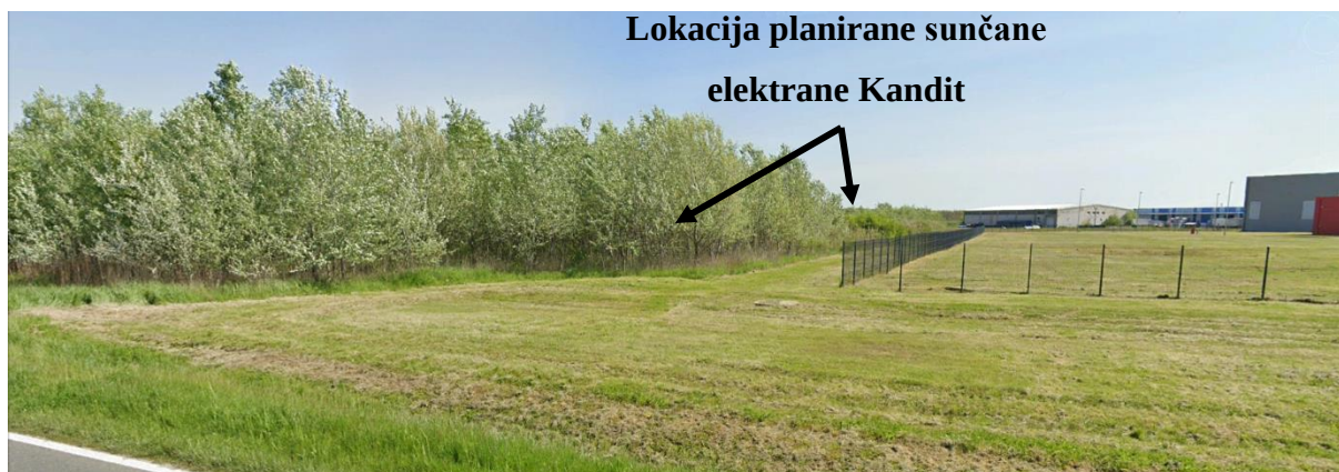
Slika 37. Lokacija planirane sunčane elektrane (pogled sa DC 417)
