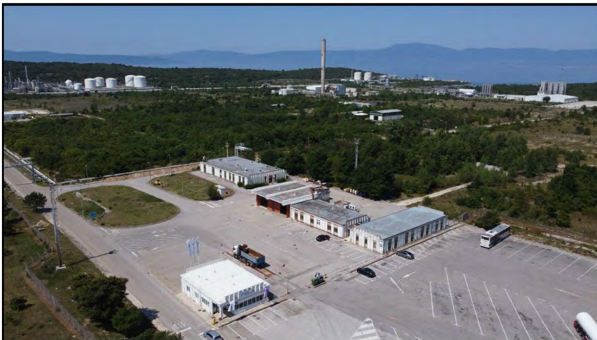
Slika 6. Objekt glavne ulazne portirnice i vatrogasne brigade i transporta. Pogled iz zraka prema sjeverozapadu (izvor: Elaborat o prenamjeni postojećih građevina za potrebe odlagališta plovnih objekata Adria Polymers Omišalj)
