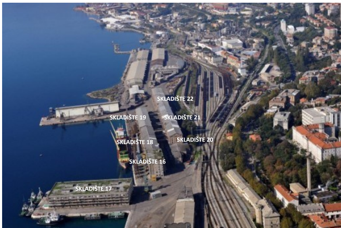
Slika 9.14.1. Pogled na skladišta 16, 17, 18, 19, 20, 21, 22
