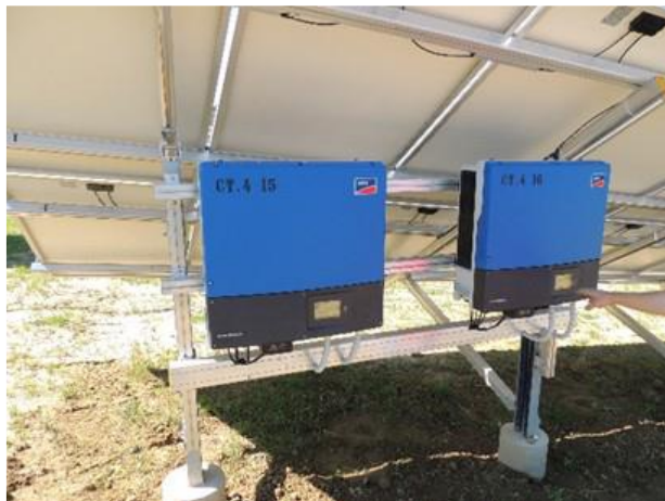
Slika 1.6 Koncept smještaja izmjenjivača male snage
