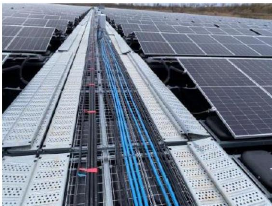
Slika 2.4 Način polaganja kabela
