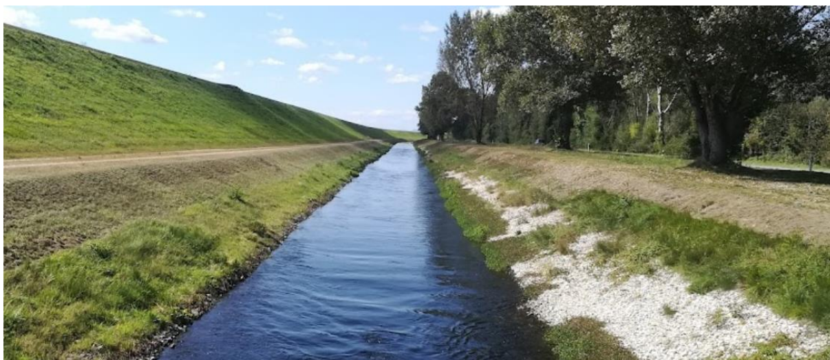
Slika 3.22 Drenažni jarak
