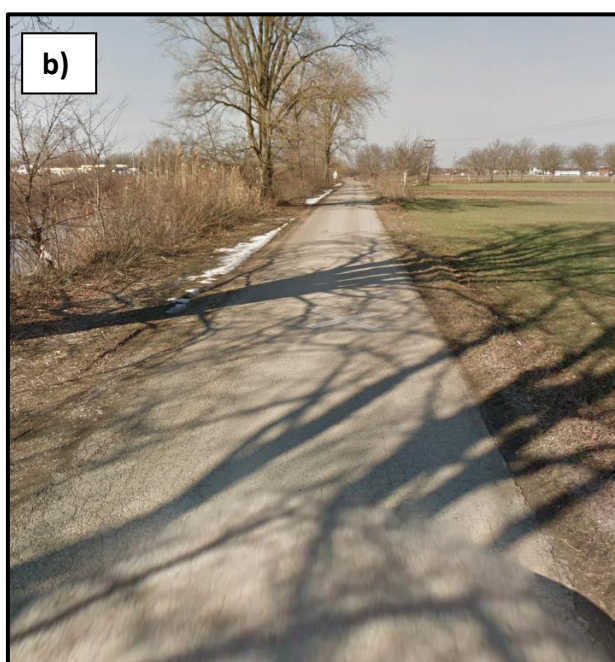
Slika 3.1.10-3. Ceste u području zahvata: (a) cesta uz sjevernu granicu parcela na kojima su planirane SE Vinkovci I i SE Vinkovci II, i (b) cesta uz lijevu obalu Bosuta kojom su trasirani priključci sunčanih elektrana na javni EES (spojni kabel varijanta 1)
