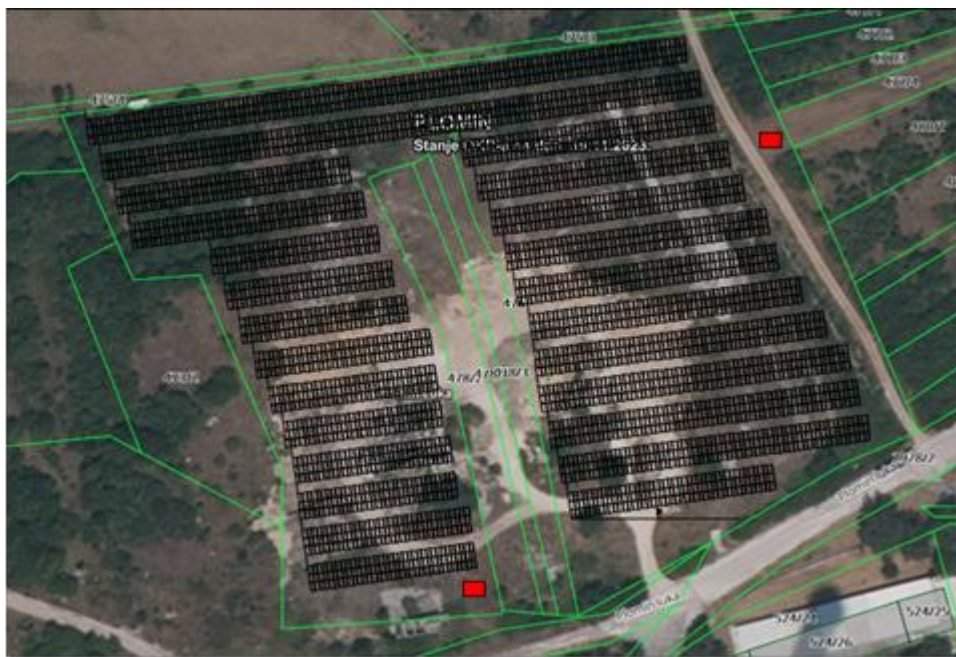
Sl. 1-13: SE Tvorničko dvorište sjever
