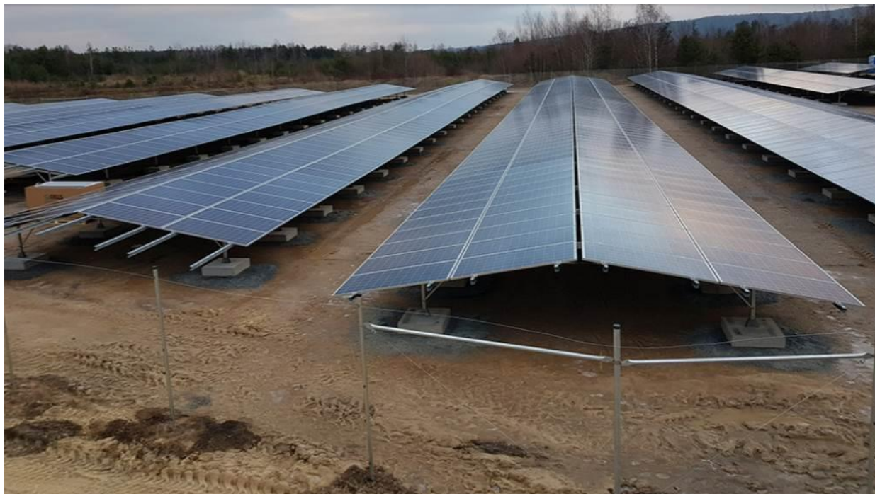
Sl. 1-4: Varijanta smještaja FN modula u konfiguraciji istok-zapad
