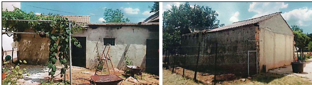
Slika 2. Prikaz predmetne postojeće građevine
