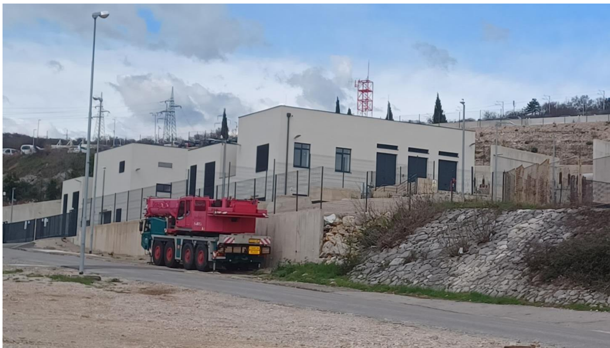
Slika 2.3-1 Postojeća TS 110/35 kV INA RNR
