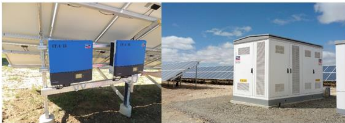
Slika 2.1-3 Koncept smještaja izmjenjivača
