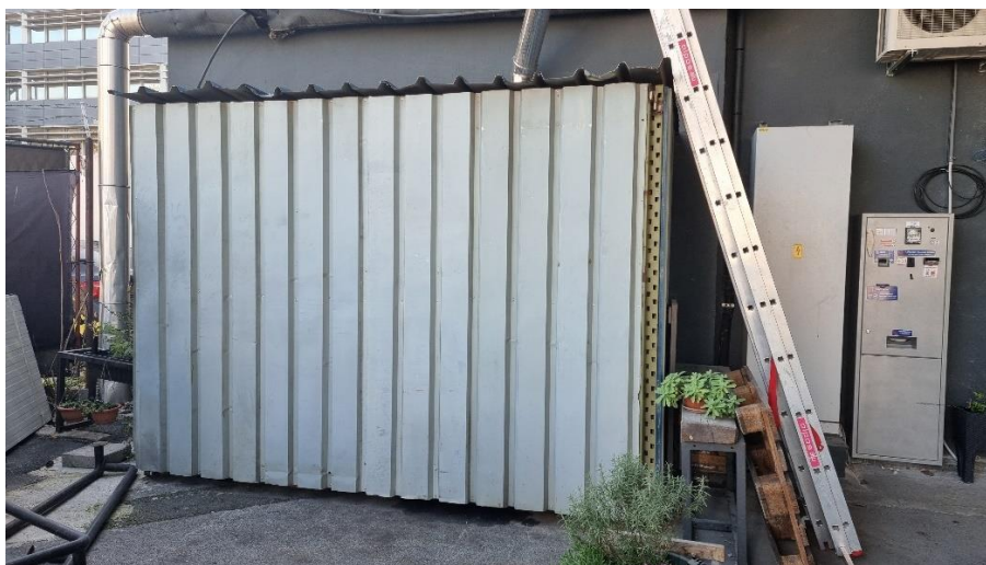
Slika 1.12 Ograđeni prostor sa tankom za lož ulje izvan pivovare
