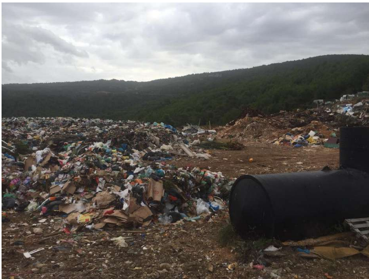
Slika 23 Odlagalište s vidljivim nedostatkom vegetacijskog pokrova
