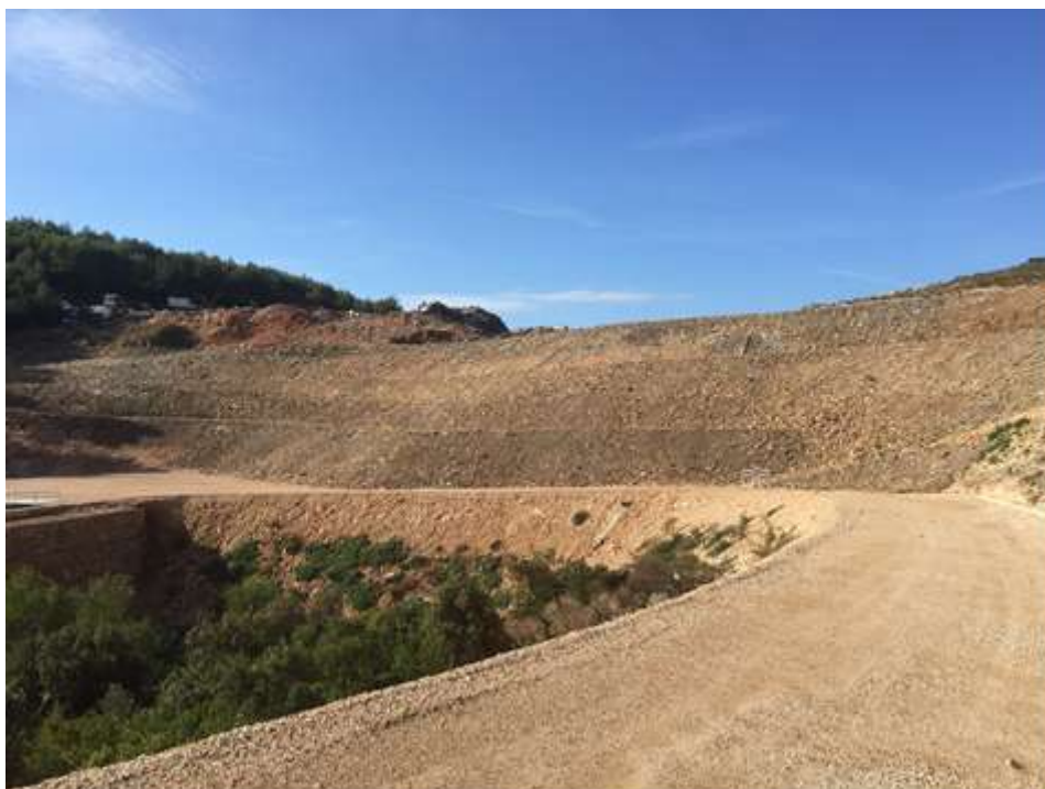
Slika 1 Sanacija požarišta na odlagalištu otpada „Prapatna“, Jelsa , studeni 2017.g.
