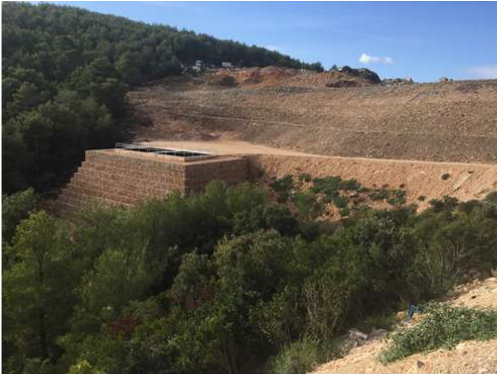
Slika 2 Izvedeni radovi prve etape na odlagalištu otpada „Prapatna“, Jelsa , studeni 2017.g.
