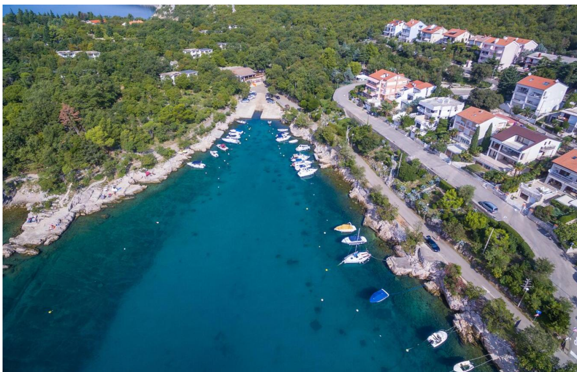
Slika 2. Pogled iz zraka - bazen Brščanovica (predsezona)
