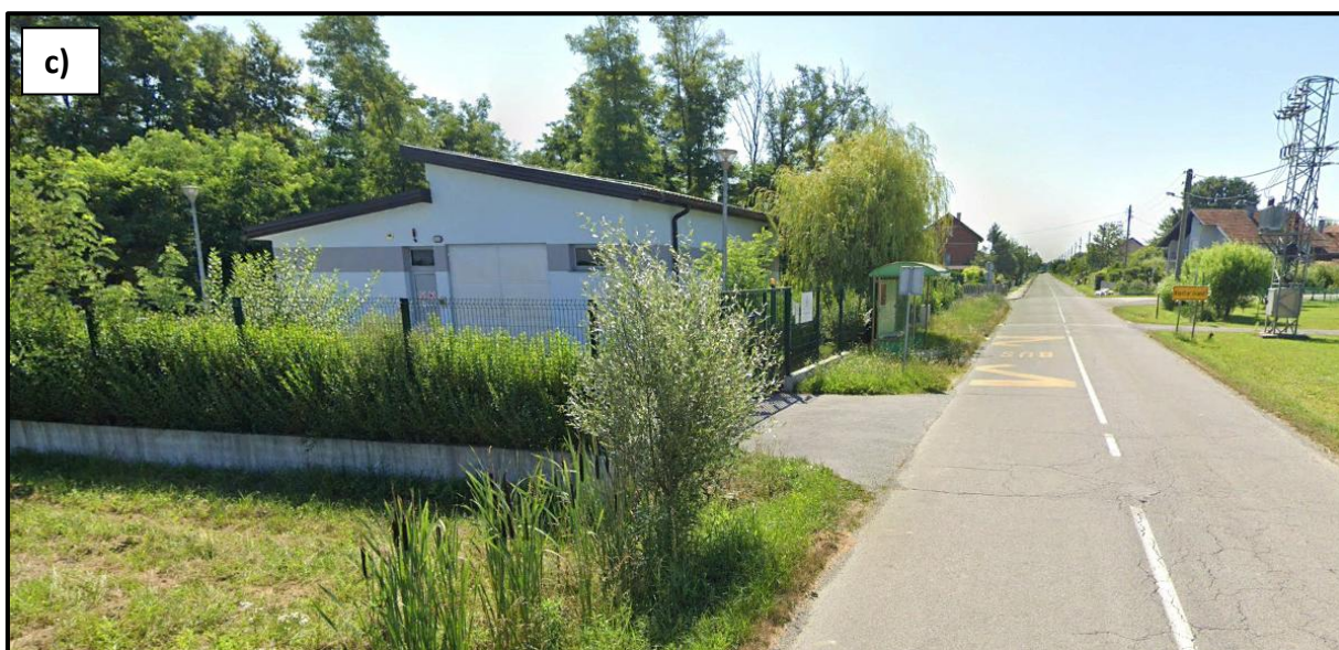
Slika 2.1-2. Fotografije područja PS Ivanić-Grad: (a) i (b) površina na kojoj je planirana sunčana elektrana; (c) PS Ivanić-Grad (lijevo) i trafostanica na koju je spojena PS Ivanić-Grad (desno)
