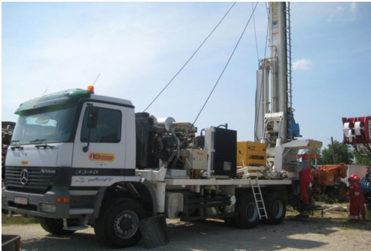
Slika Bušaće postrojenje Soilmec G-25 AD
