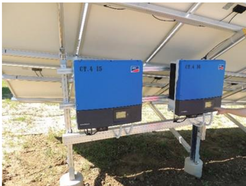
Slika 1.6 Koncept smještaja izmjenjivača male snage
