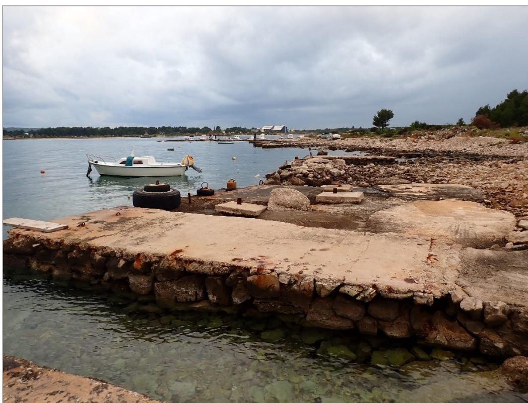
Slika 13. Postojeća situacija na lokaciji zahvata (morski dio-postojeći molovi)
