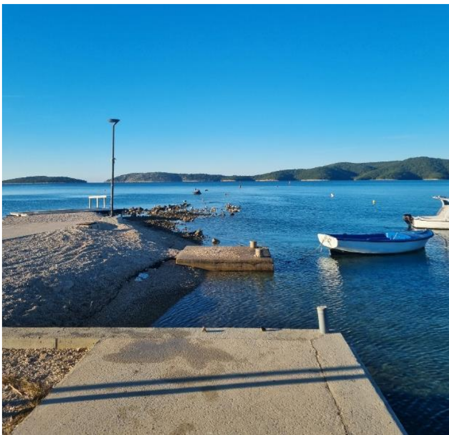
Slika 50. Betonski plato, nasuta plaža i potopljeni lukobran s istočne strane uvale
