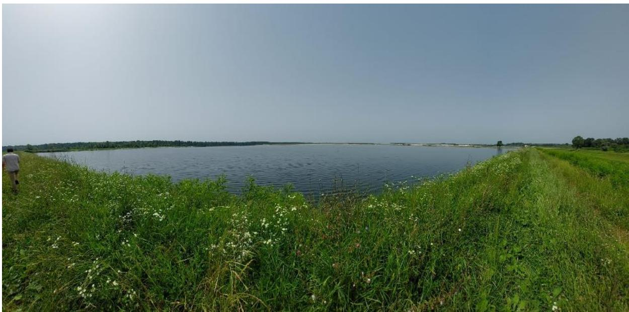
Sl. 2.2-5 Prikaz kazete K-4 koja služi za prihvat vode nakon procesa neutralizacije i koja će nakon izgradnja sunčane elektrane služiti za prihvat procijedne i oborinske vode
