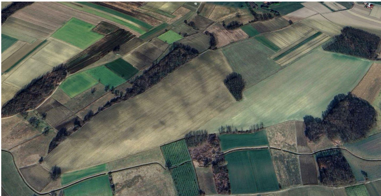
Slika 34. Uža lokacija zahvata, pogled iz zraka
