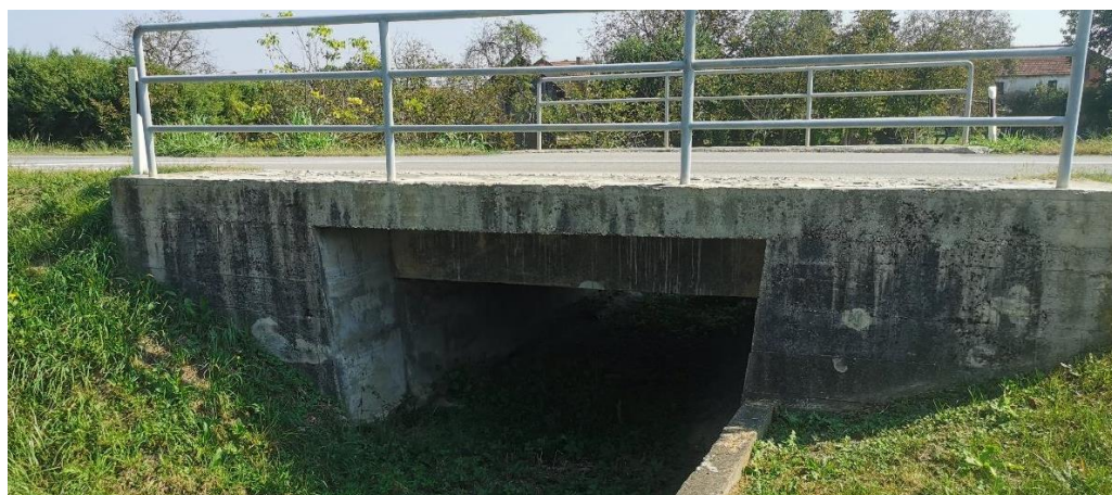
Fotografija A-7. Bočni pogled na propust 5
