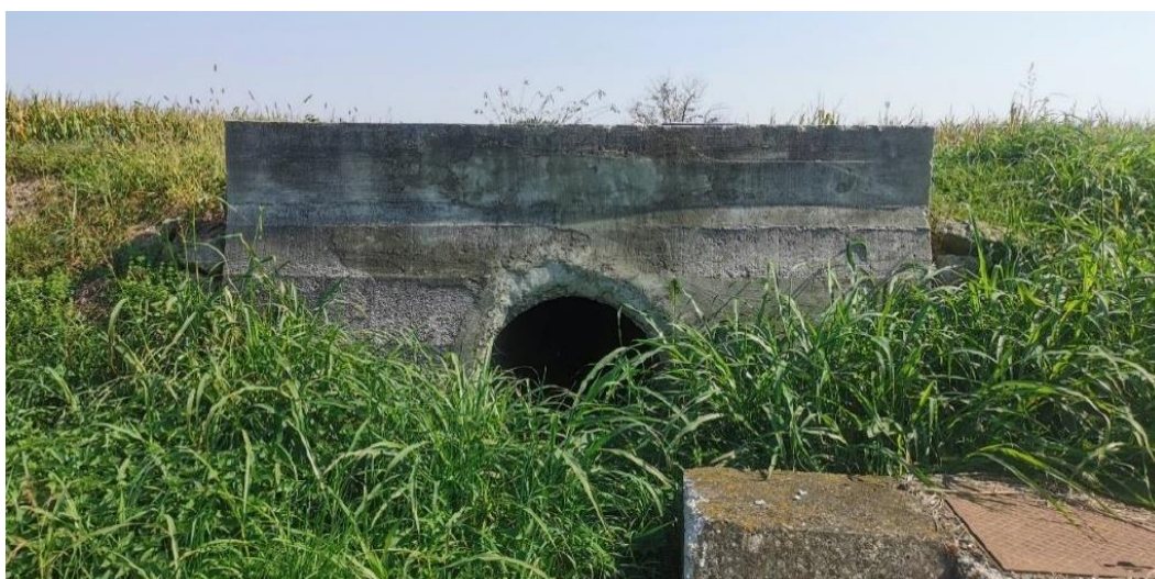
Fotografija A-3. Bočni pogled na propust 1
