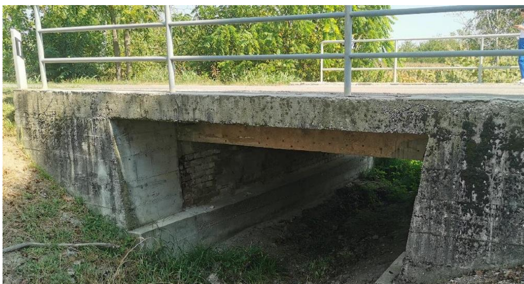
Fotografija A-6. Bočni pogled na propust 4
