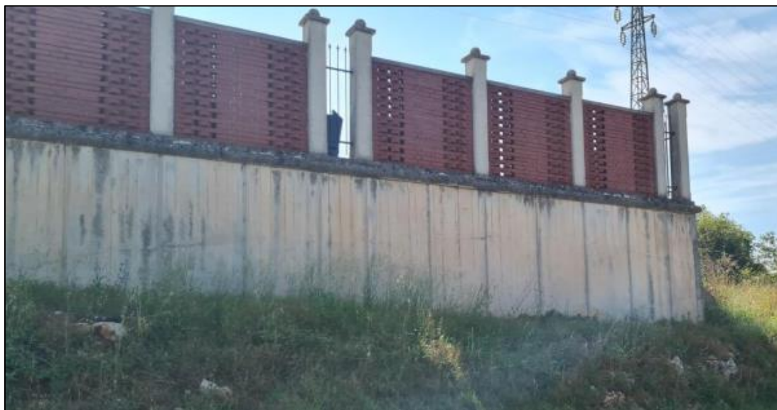
Slika 4. Ogradni zid postojećeg groblja
