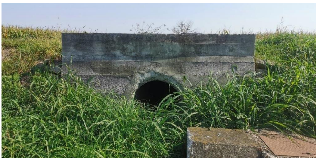
Fotografija A-3. Bočni pogled na propust 1
