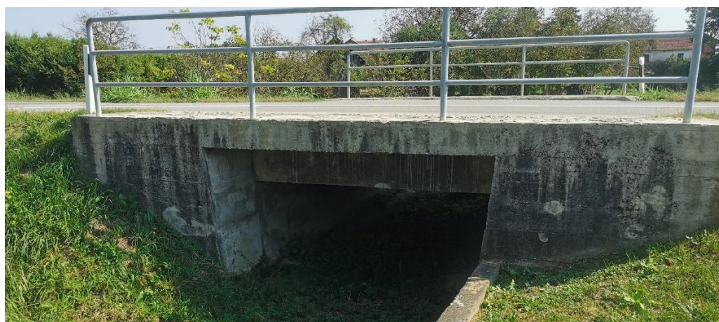
Fotografija A-7. Bočni pogled na propust 5
