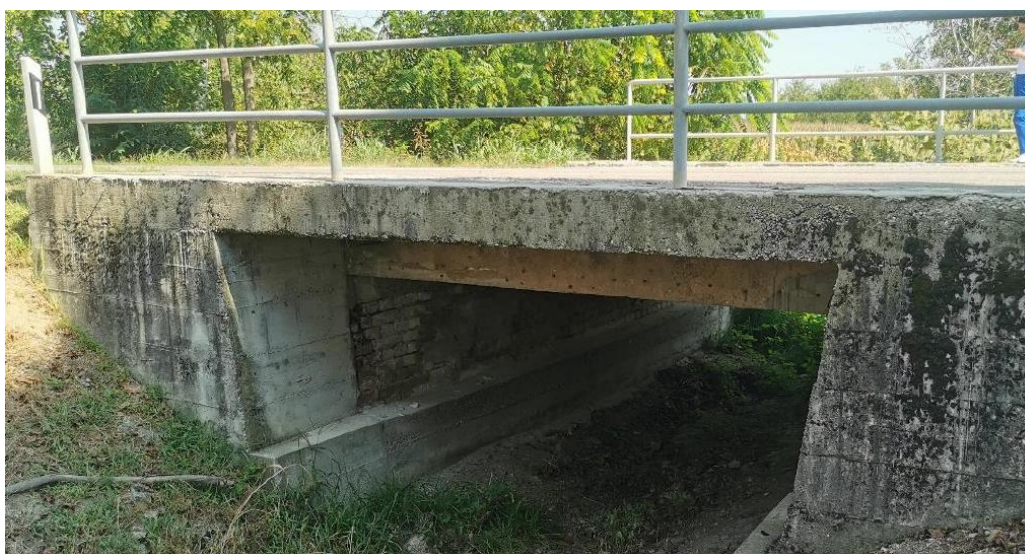
Fotografija A-6. Bočni pogled na propust 4
