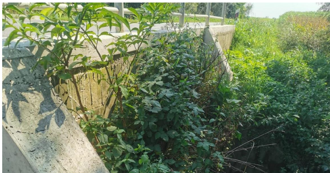
Fotografija A-4. Bočni pogled na propust 2
