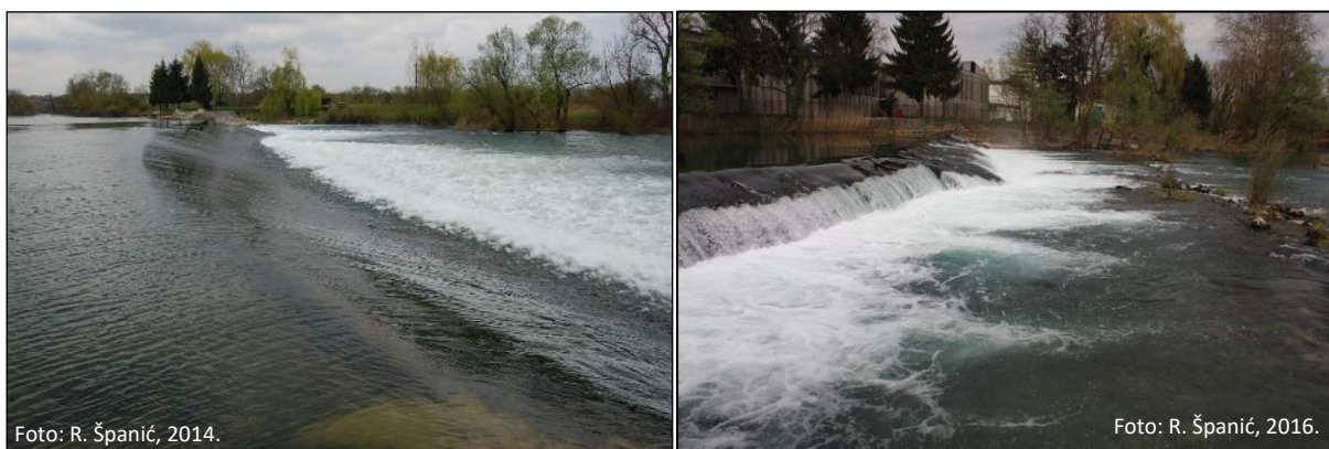
Slika 3.2-5. Postojeća brana na lokaciji ušća Mrežnice u Koranu na Turnju (lijevo) i brana na Mrežnici u Mrzlom Polju (desno)
