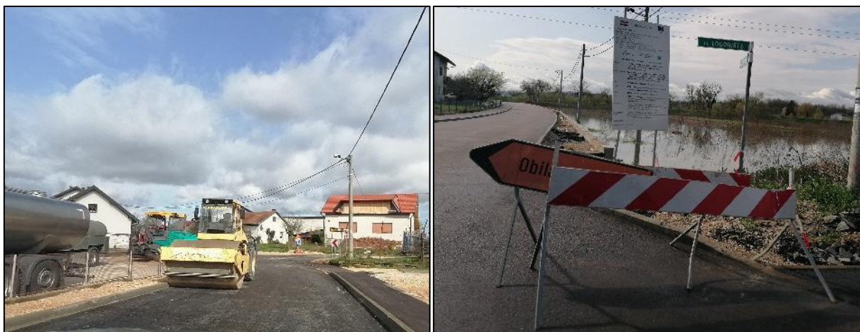
Slika 3.2-6. Završni radovi na gradnji odvodnje i rekonstrukciji vodovodne infrastrukture u naselju Mala Švarča (foto: R. Španić, 30.3.2025. )
