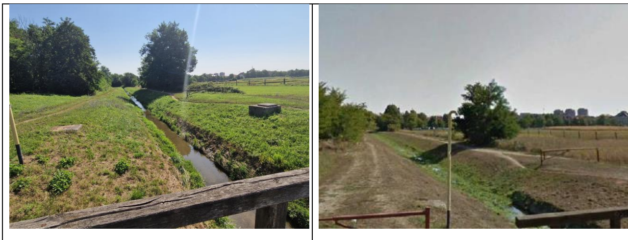
Slika 2-5: Vodotok Štefanovec u postojećem stanju na dijelu izvedbe dionice "I"
