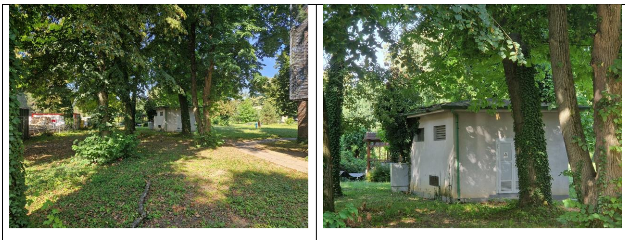
Slika 2-4: Postojeća trafostanica TS 166 u krugu Agronomskog fakulteta je mjesto priključenja sustava na elektrodistribucijsku mrežu
