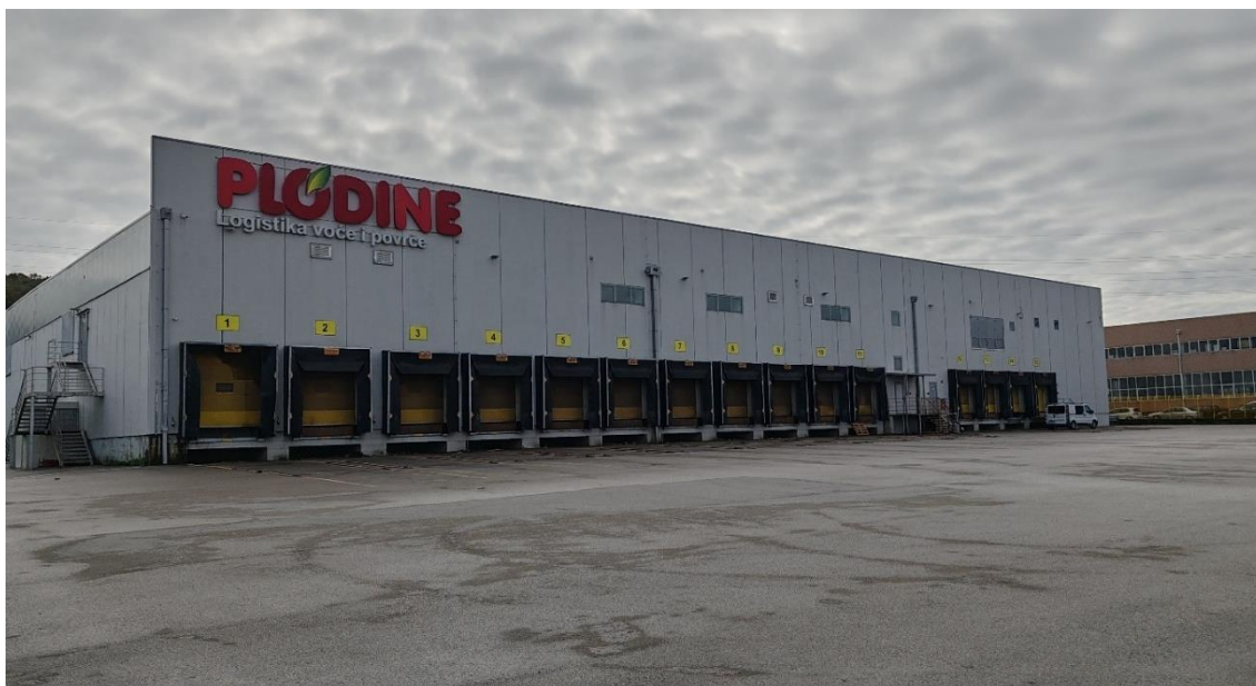
Slika 3. Postojeći objekt u koji je planirano preseljenje postrojenja iz Grada Rijeke
