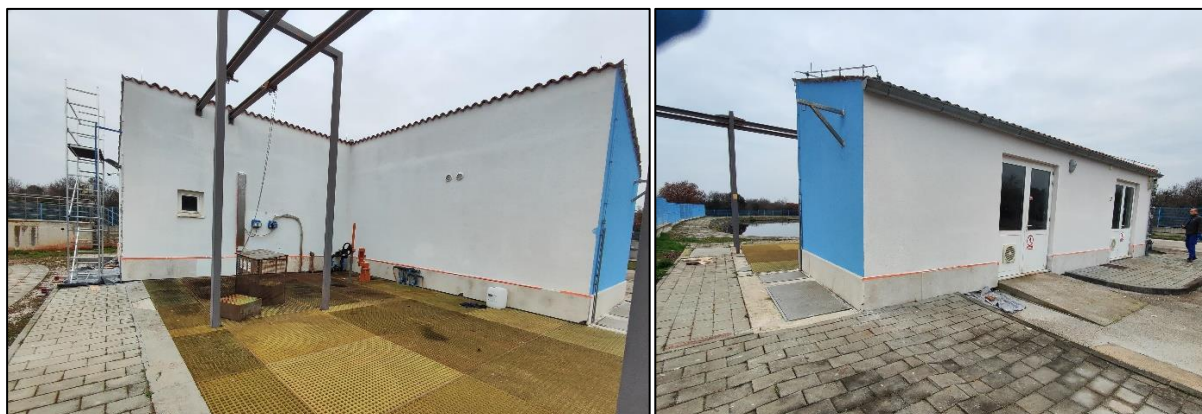
Slika 4 Zgrada za obradu otpadnih voda (objekt uređaja za pročišćavanje)
