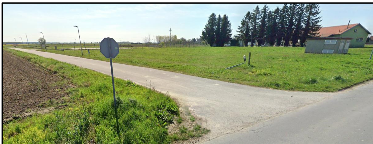
Slika 2.1-2. Pogled na asfaltiranu nerazvrstanu cestu koja se odvaja s lokalne ceste LC26102 i kojom je trasiran priključak SE Virje 500 na javni elektroenergetski sustav (trafostanica je na desnoj strani fotografije)
