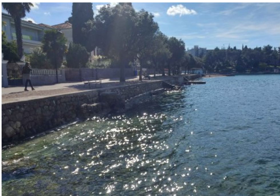
Slika 6.8. Postojeća betonska stubišta i manji betonski molovi za pristup moru (izvor: RiEKO-LAB d.o.o.)
