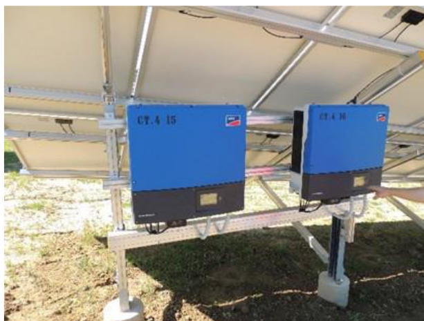
Slika 1.6 Koncept smještaja izmjenjivača male snage
