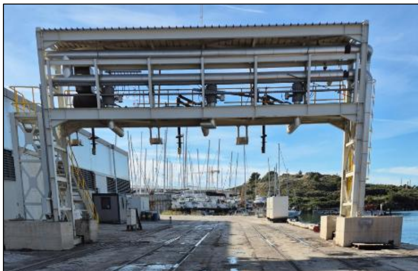
Slika 1: Prikaz postojećeg pretakališta na vezu br. 1
