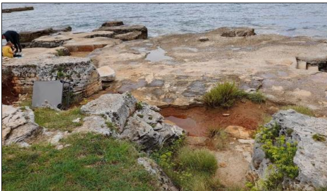
Slika 6. Postojeći betonski platoi – poravnanje i oblaganje kamenom škriplom
