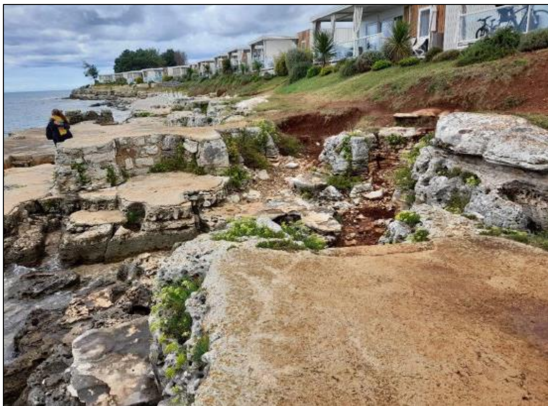
Slika 5. Postojeće stanje s vidljivom erozijom obale
