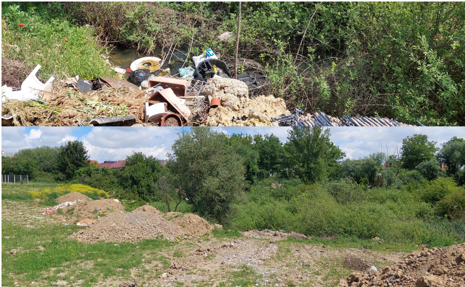
Sl. 3.11.8: Postojeće stanje kanala
