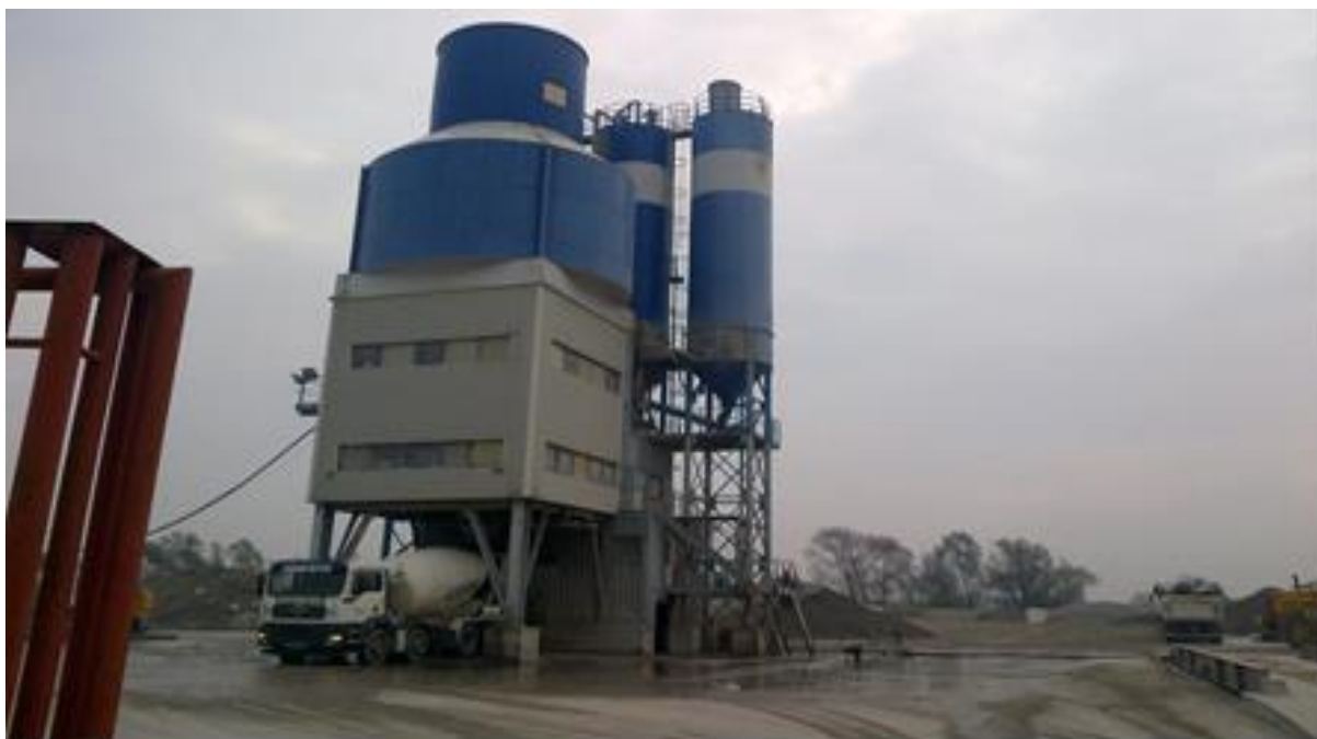
Slika 1. Betonara na lokaciji Strovarska 5, Sesvetski Kraljevec
