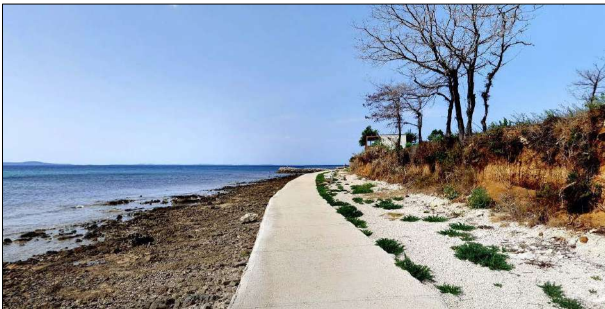
Slika 10. Prikaz lokacije zahvata u blizini mola Mletak (pogled prema zapadu, Street view, 2017.)
