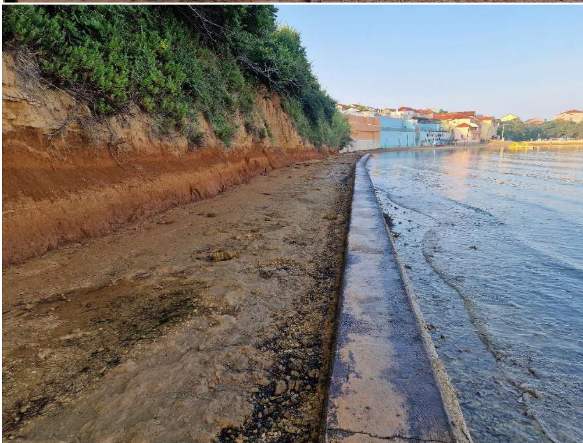
Slika 6. Postojeće stanje na lokaciji – južni dio zahvata (izvor: Coastal Engineering d.o.o.)
