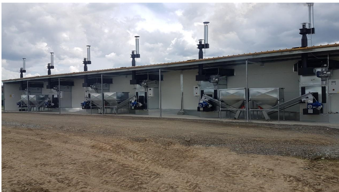
Slika 13. Postojeći termogeneratori HT-AD 95 na postojećem dijelu građevine (Izvore: Investitor / Herbas d.o.o.)
